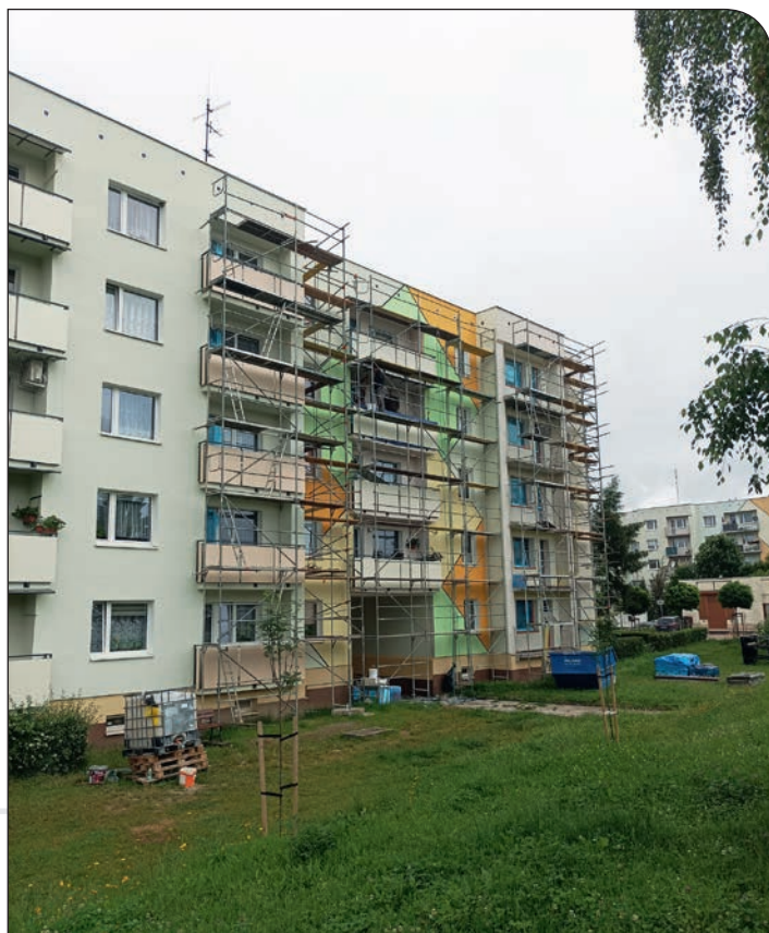
os. Różane 41a balkony w trakcie modernizacji
