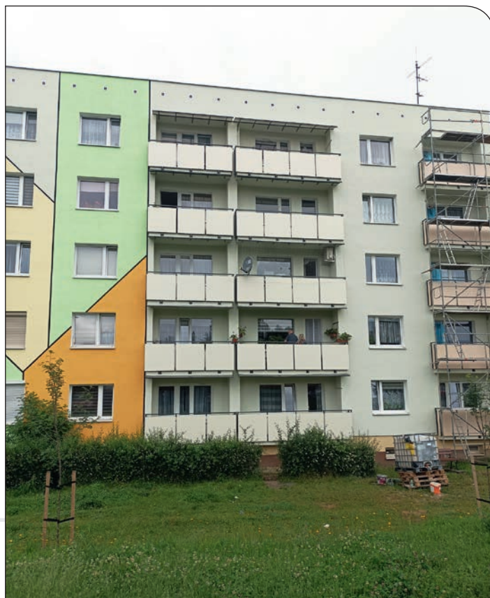
os. Różane 40a balkony po remoncie
